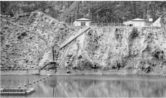
主动源重复探测项目建设现场
