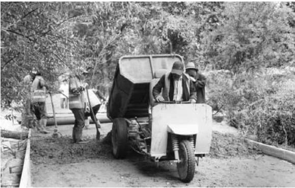
通村道路建设
