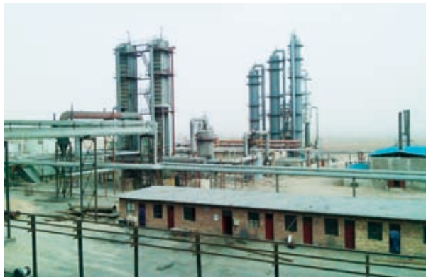
晋昌源公司化工产区
