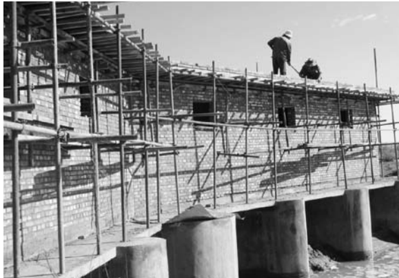
河西村杨家沟进泄水闸维修工程
