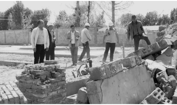
拆除违章建筑
