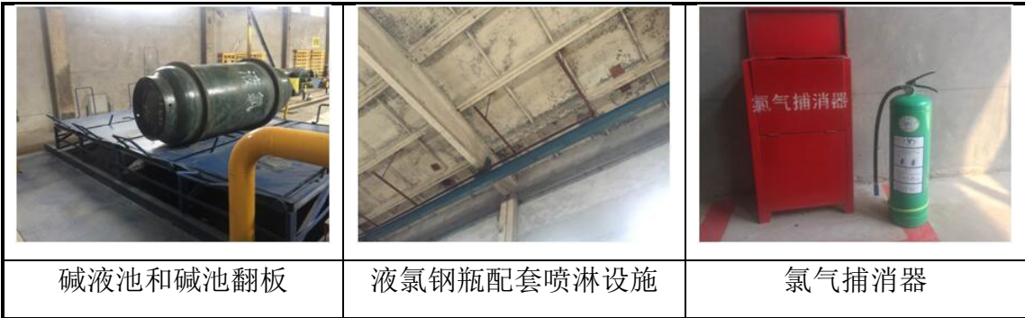
图6.7-1 常用的液氯风险防范装置设备
